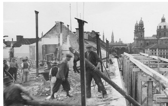
Abbruch der Gebäude an der Ludwigstraße zwischen Von-der-Tann- und Galeriestraße, im Hintergrund: Neues Rathaus, Feldherrnhalle und Theatinerkirche, 21. Mai 1937 Bayerisches Hauptstaatsarchiv, OBB Fotos 8143
