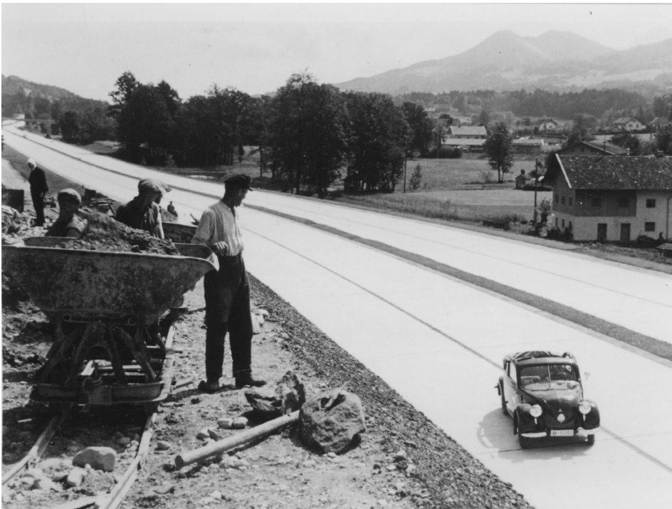
Bau der Reichsautobahn von München bis zur Landesgrenze im Inntal, 1936 (Staatsarchiv München, Autobahndirektion Südbayern 2043)
