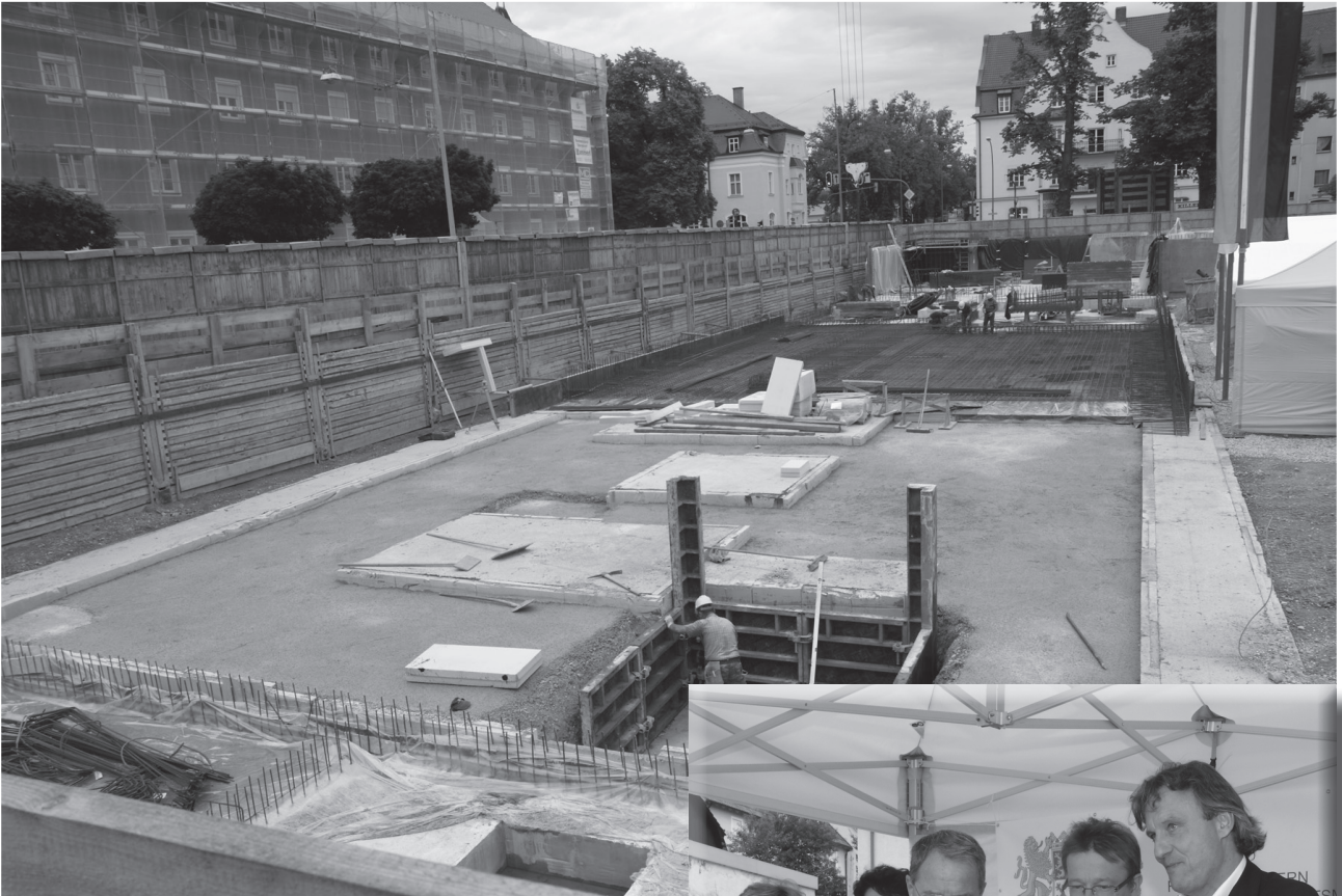
oben: Blick über die Baustelle
