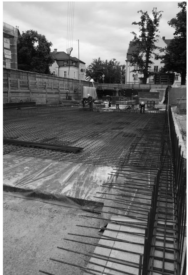
Blick über die Baustelle
