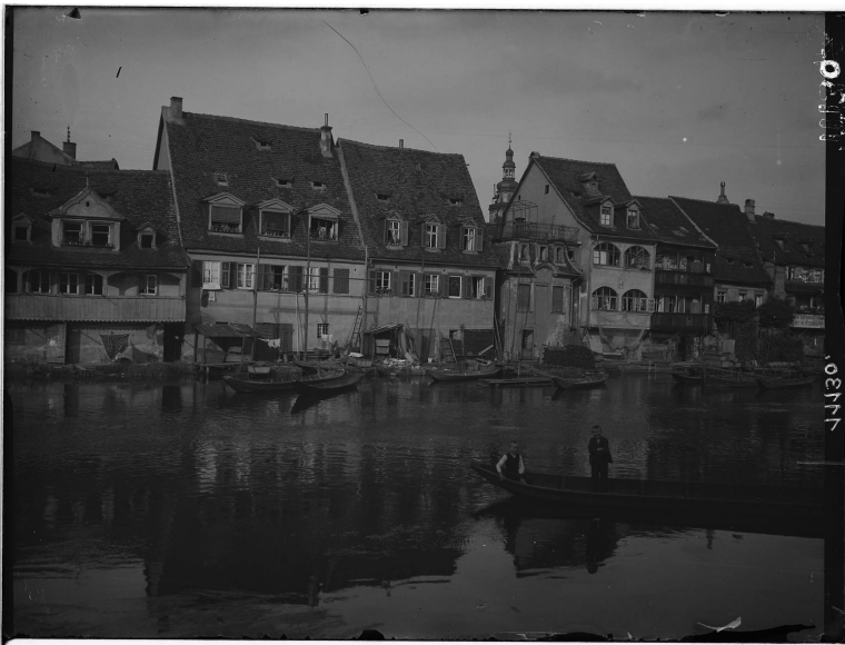
Ansicht von Bamberg – Häuserzeile an der Regnitz, 24.8.1906
